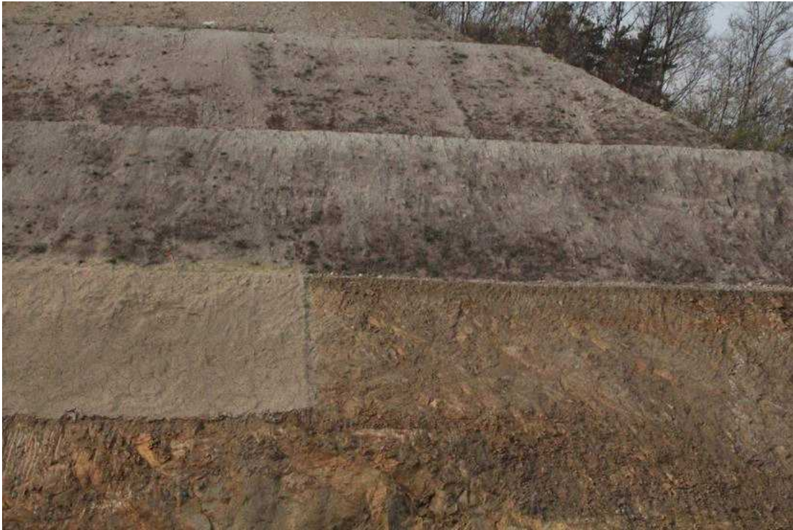
STA.8+730 중단부 녹화후
