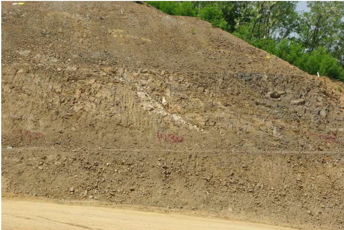
STA.8+730 하단부 녹화전
