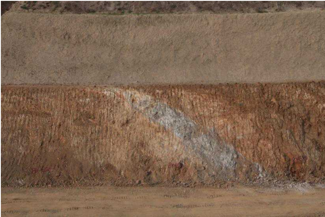
STA.8+670 하단부 녹화후
