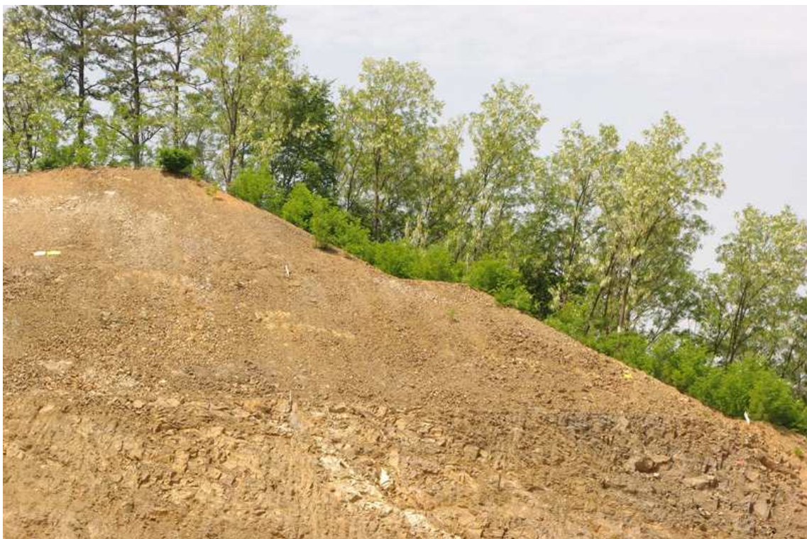
STA.8+730 상단부 녹화전
