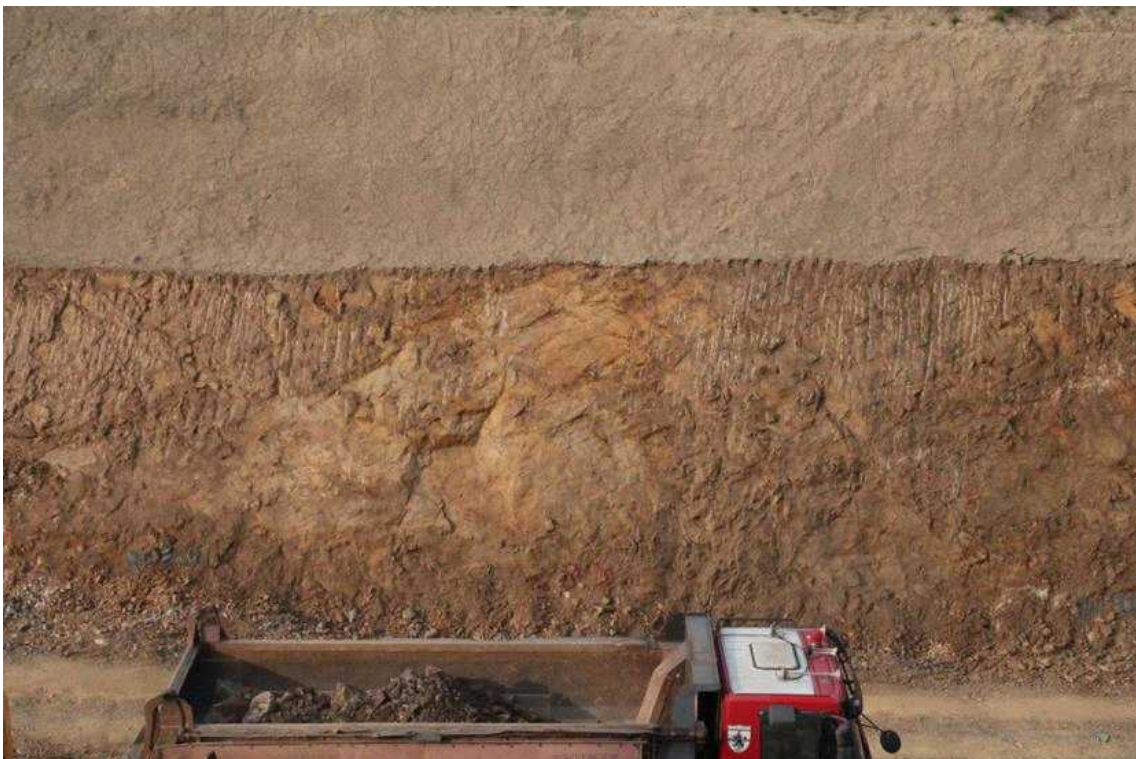
STA.8+710 하단부 녹화후
