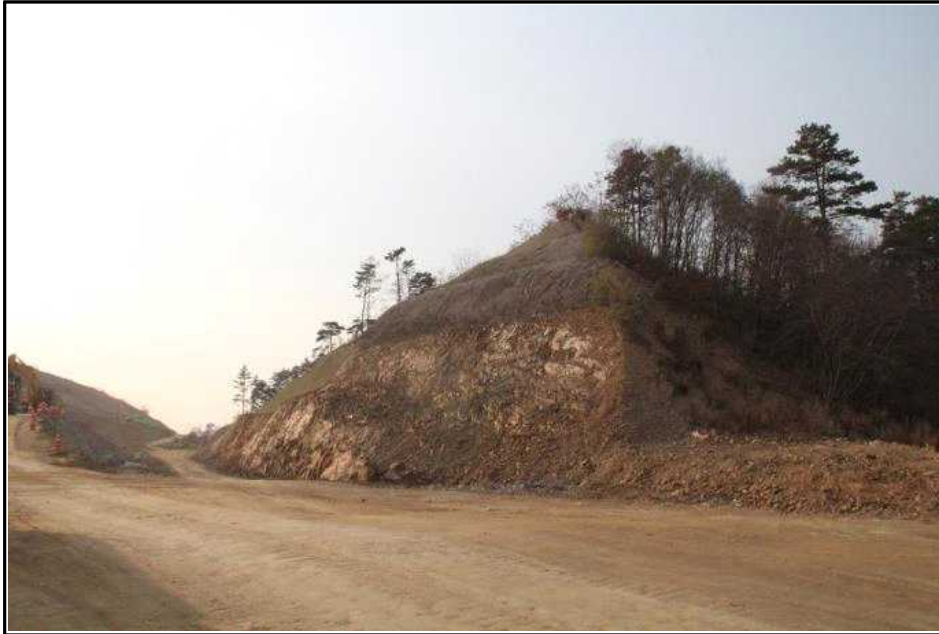
【그림 3】 깎기비탈면 시점부 측면 사진
