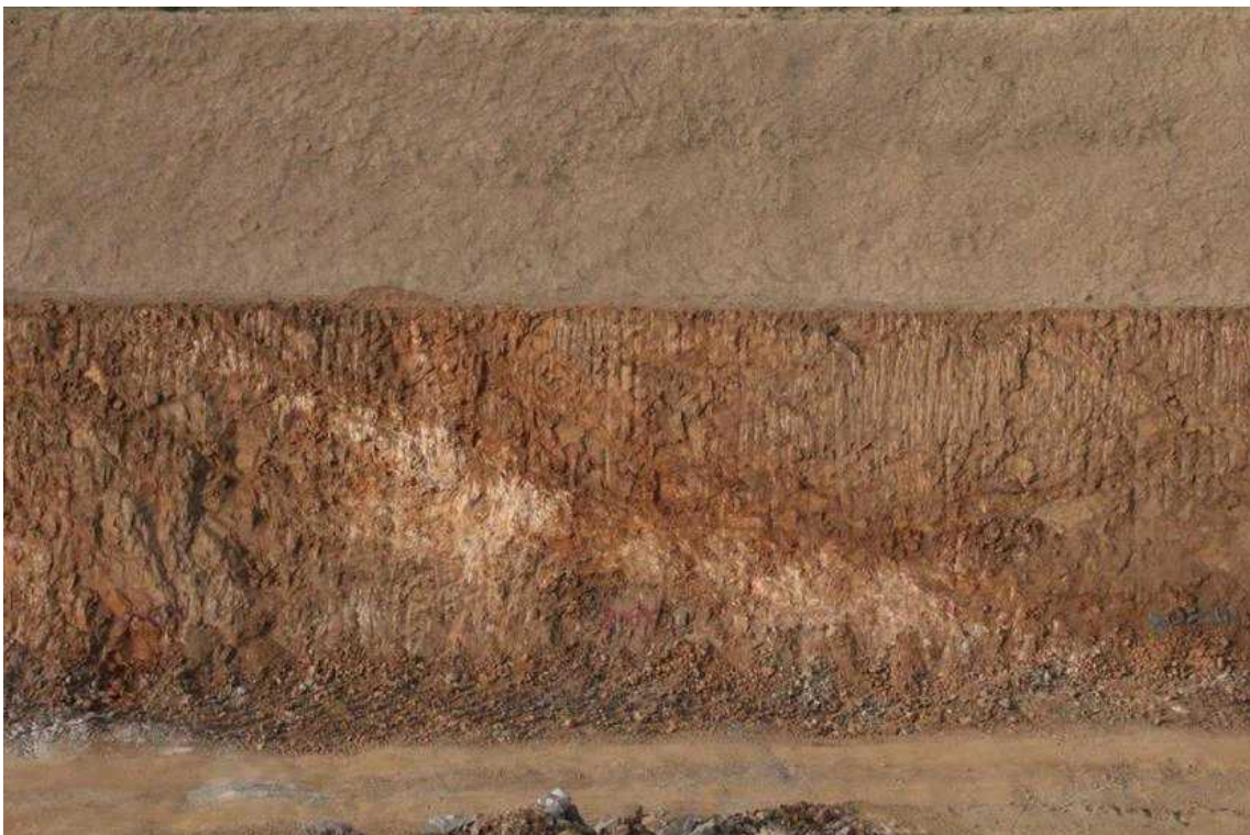
STA.8+690 하단부 녹화후
