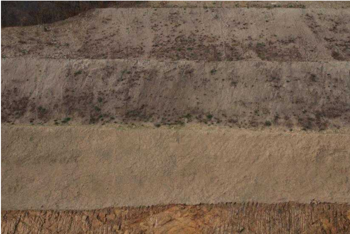
STA.8+710 중단부 녹화후
