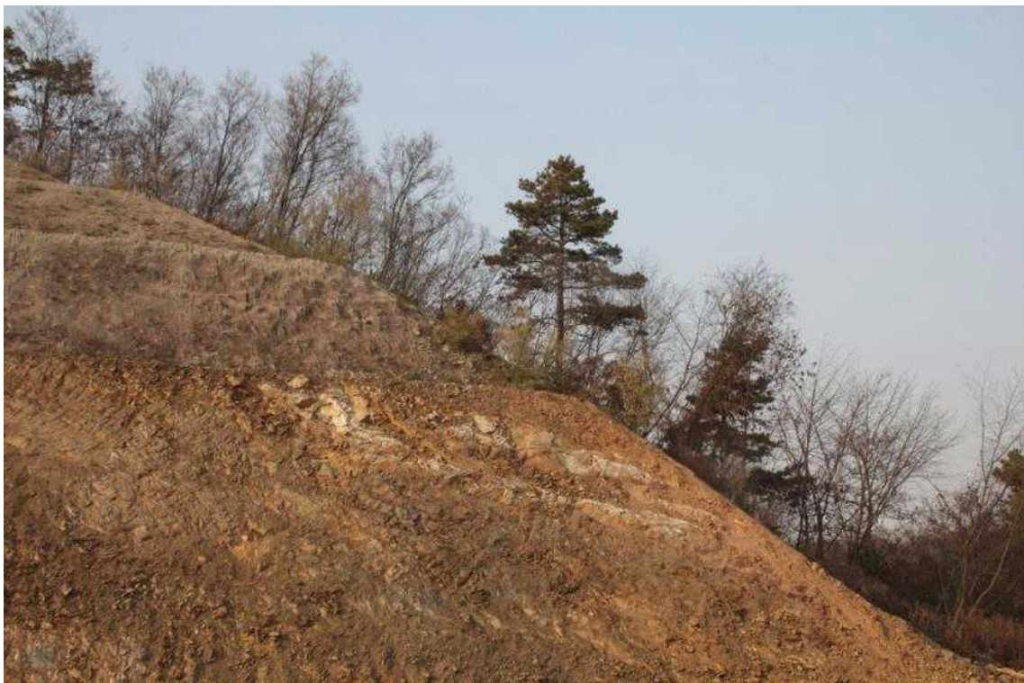
STA.8+750 상단부 녹화후
