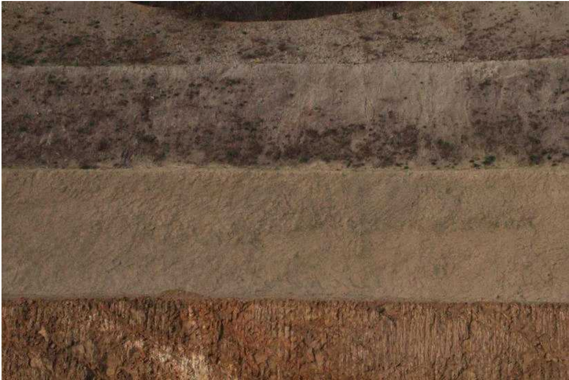
STA.8+690 중단부 녹화후
