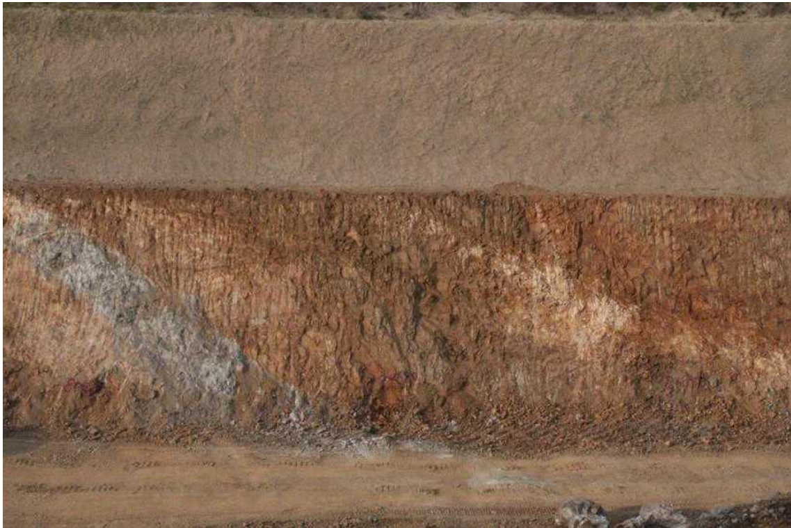
STA.8+680 하단부 녹화후
