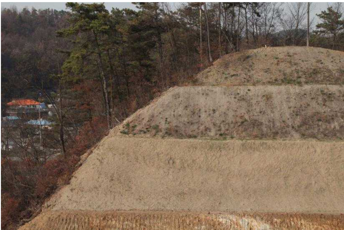
STA.8+660 상단부 녹화후
