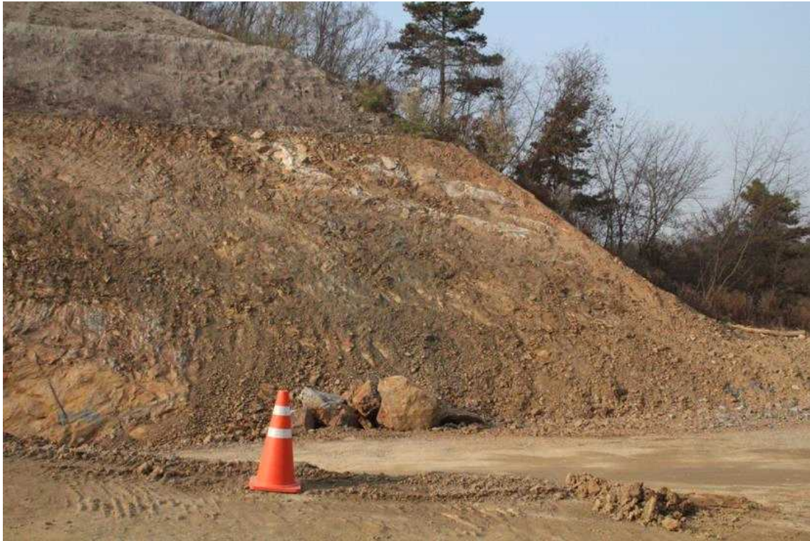
STA.8+750 하단부 녹화후
