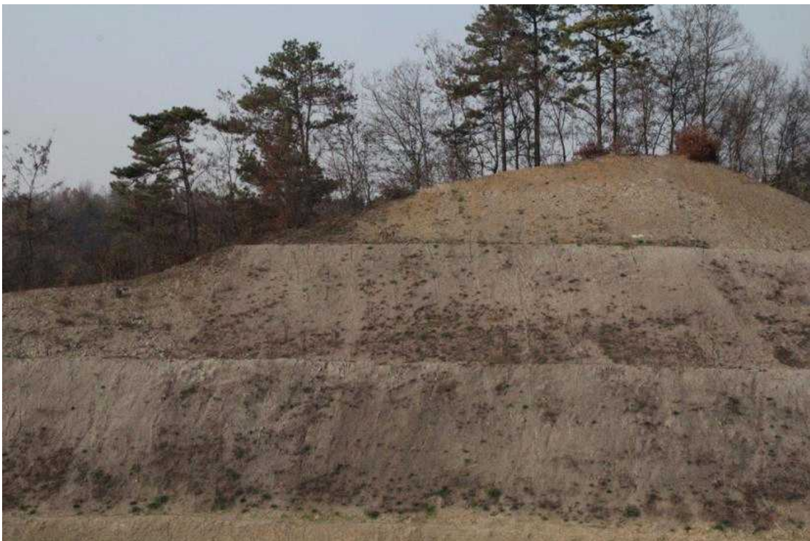
STA.8+710 상단부 녹화후
