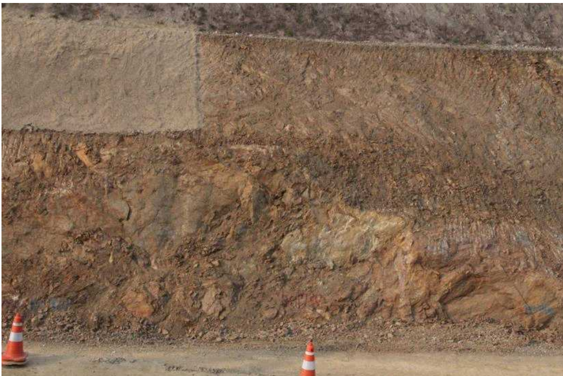
STA.8+730 하단부 녹화후
