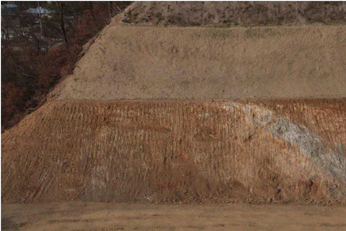
STA.8+660 하단부 녹화후
