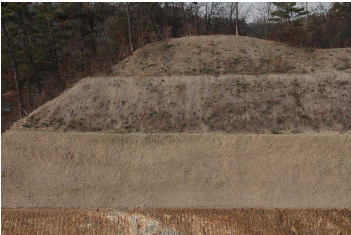
STA.8+670 상단부 녹화후
