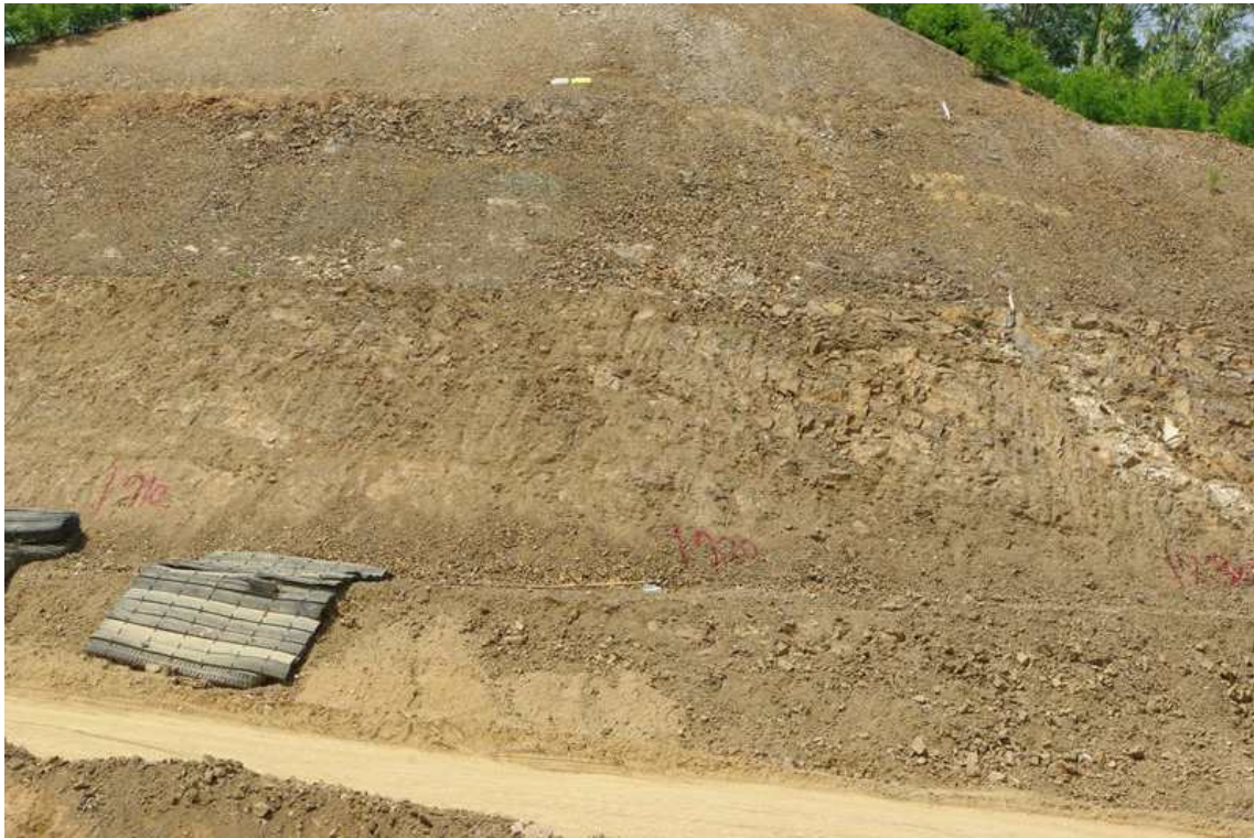
STA.8+720 하단부 녹화전
