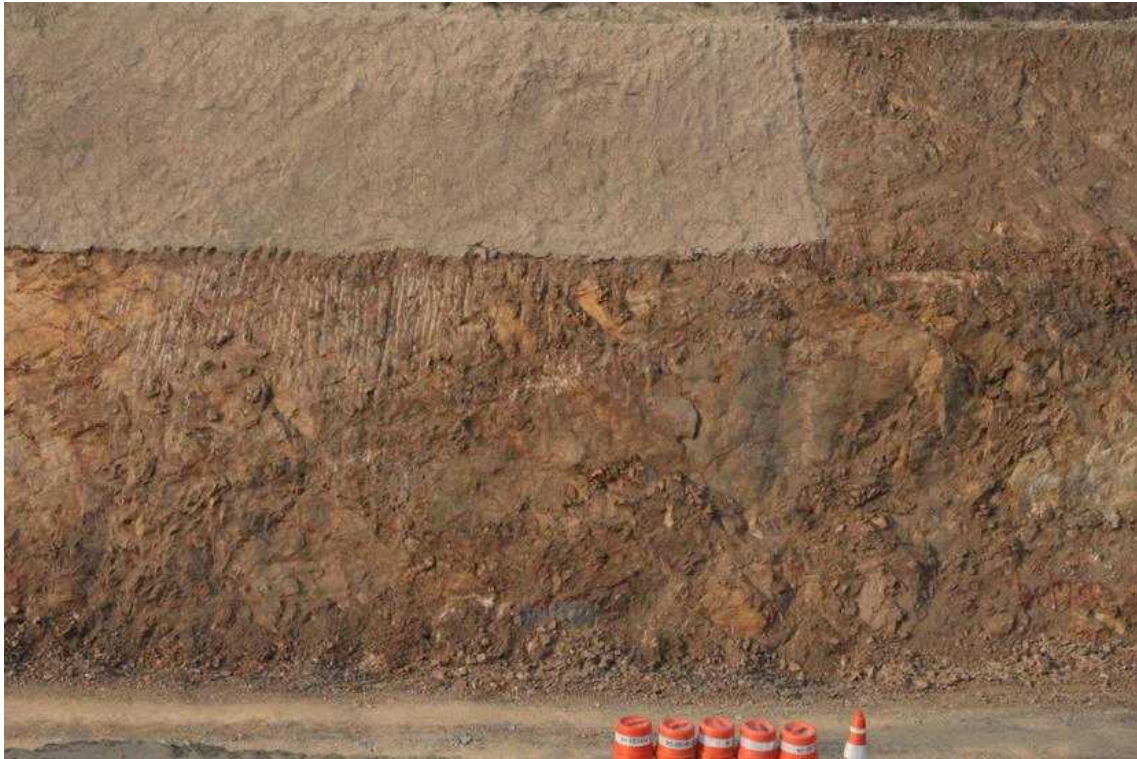
STA.8+720 상단부 녹화후
