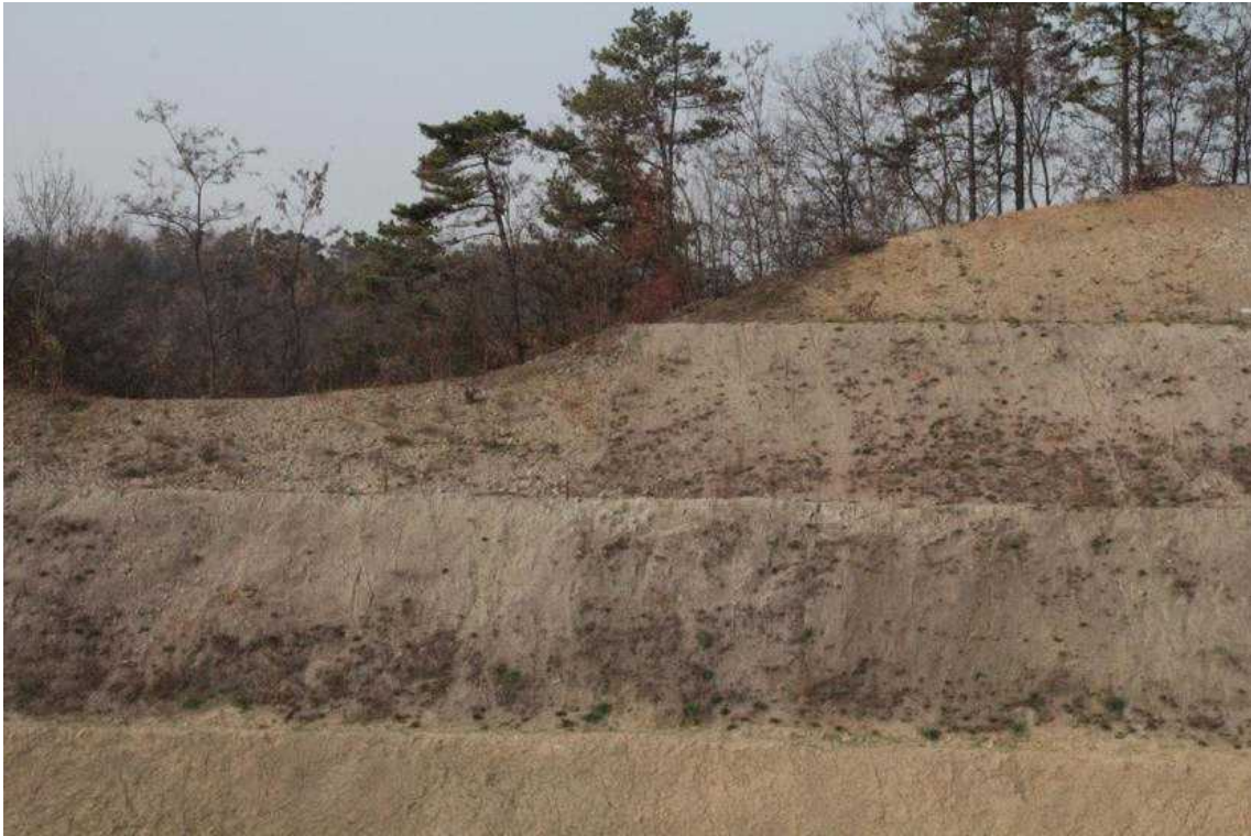
STA.8+700 상단부 녹화후
