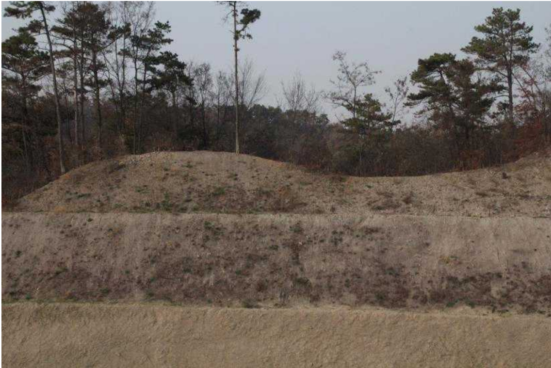
STA.8+680 상단부 녹화후
