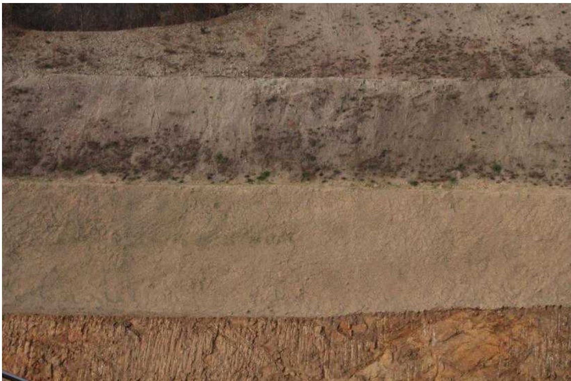
STA.8+700 중단부 녹화후
