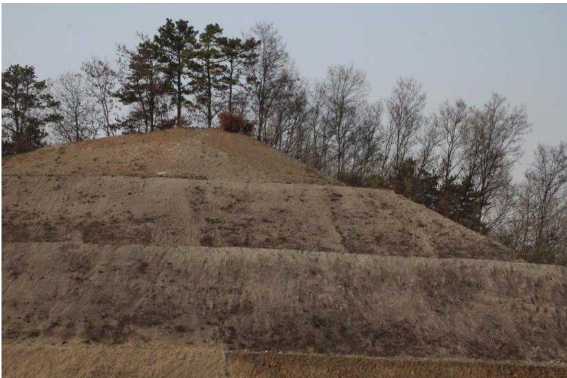
STA.8+730 상단부 녹화후
