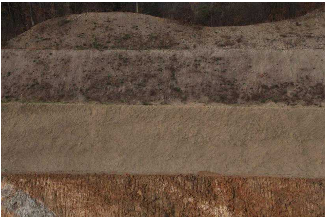
STA.8+680 중단부 녹화후
