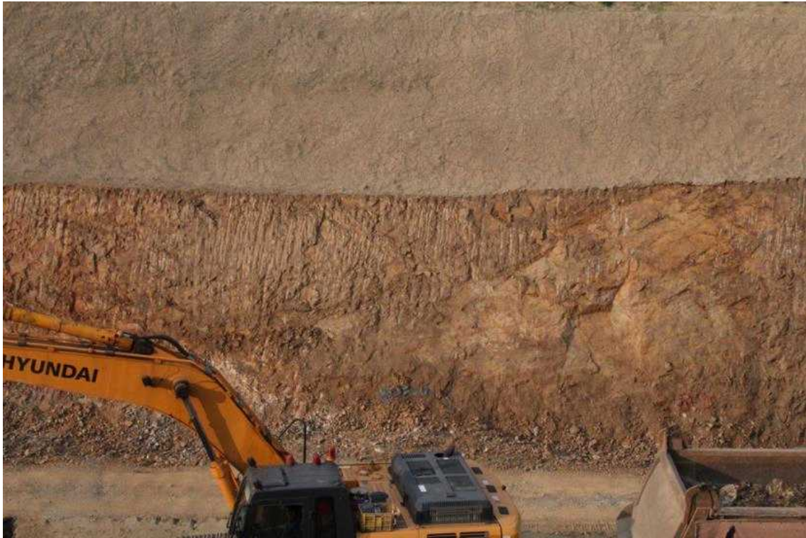
STA.8+700 하단부 녹화후
