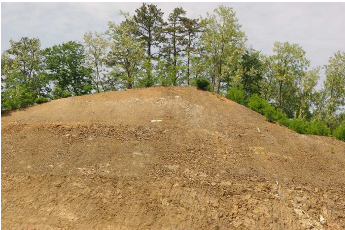
STA.8+720 상단부 녹화전
