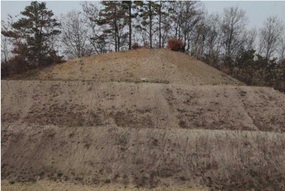
STA.8+720 상단부 녹화후
