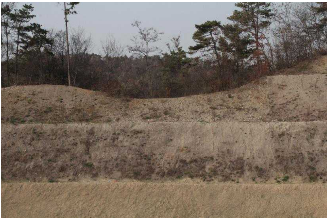
STA.8+690 상단부 녹화후
