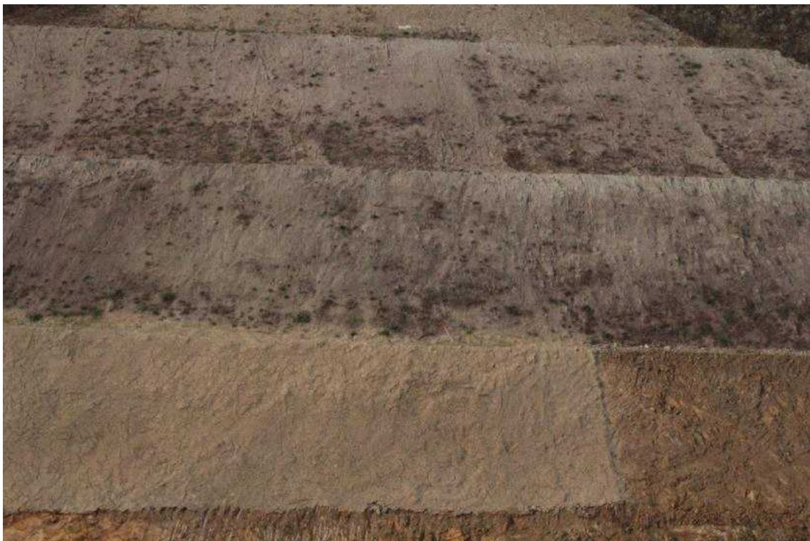
STA.8+720 중단부 녹화후
