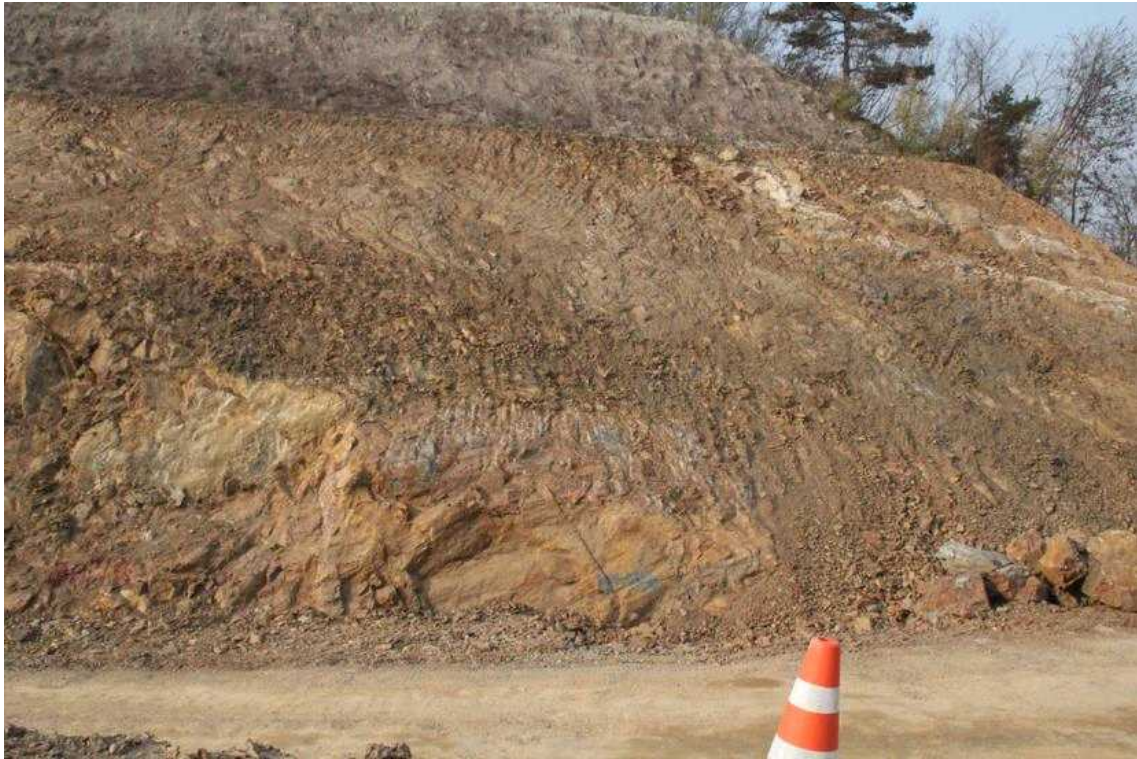
STA.8+740 하단부 녹화후
