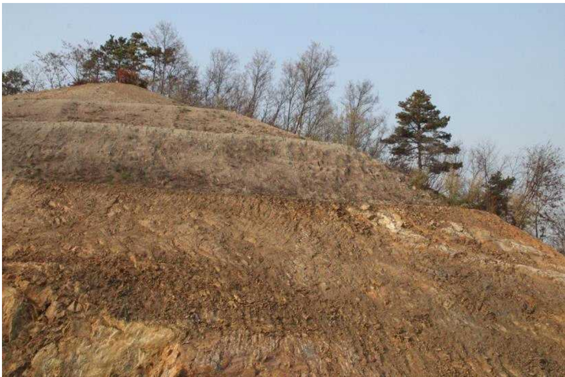
STA.8+740 상단부 녹화후
