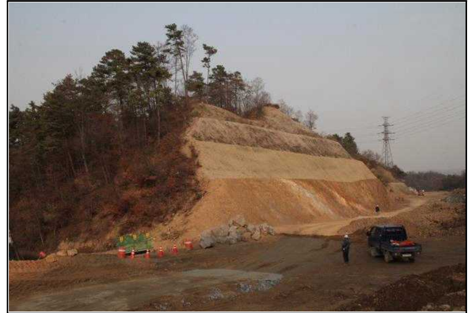
【그림 4】 깎기비탈면 종점부 측면 사진
